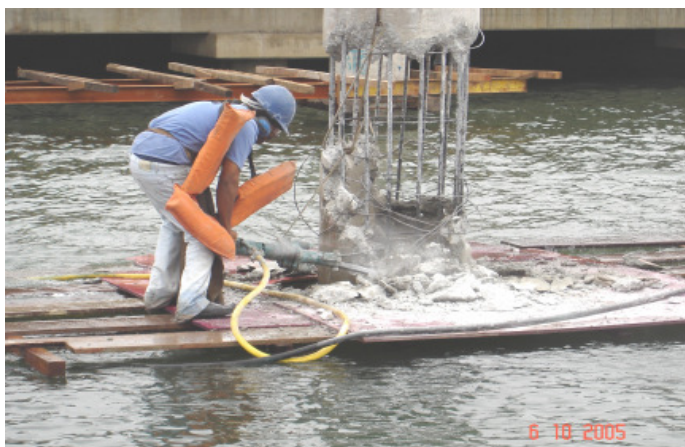
Figura 9.3 - Execução do arrasamento em uma das estacas no TECON III. Fonte: FANTI (2007)
