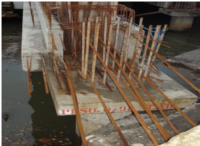
Figura 9.5 – Colocação das vigas pré-moldadas sobre as placas de cabeça. Fonte: Foto tirada durante a visita à Tecon IV (30 de abril de 2008).
