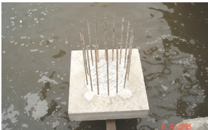
Figura 9.4 - Placa de cabeça sobre a estaca com o interior já concretado (1ª fase de concretagem). Fonte: FANTI (2007)
